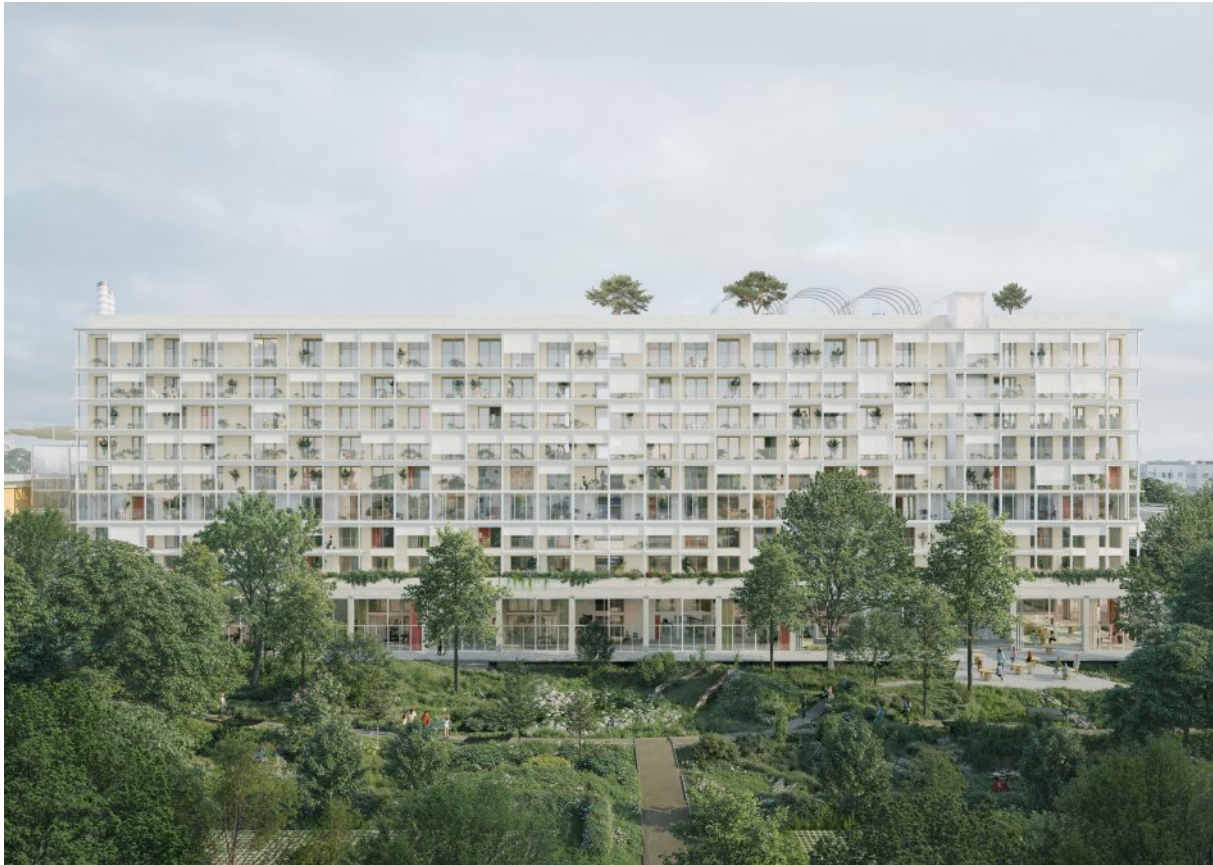
Caen, La Soda, EBA, élévation ouest.
