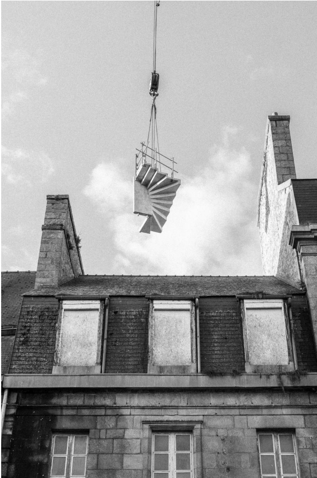
Olivier Laban-Mattei, un pan d'escalier s'élève au-dessus de la place du centre à Guingamp avant d'être déposé sur le chantier de rénovation des immeubles de la rue Ollivro.
